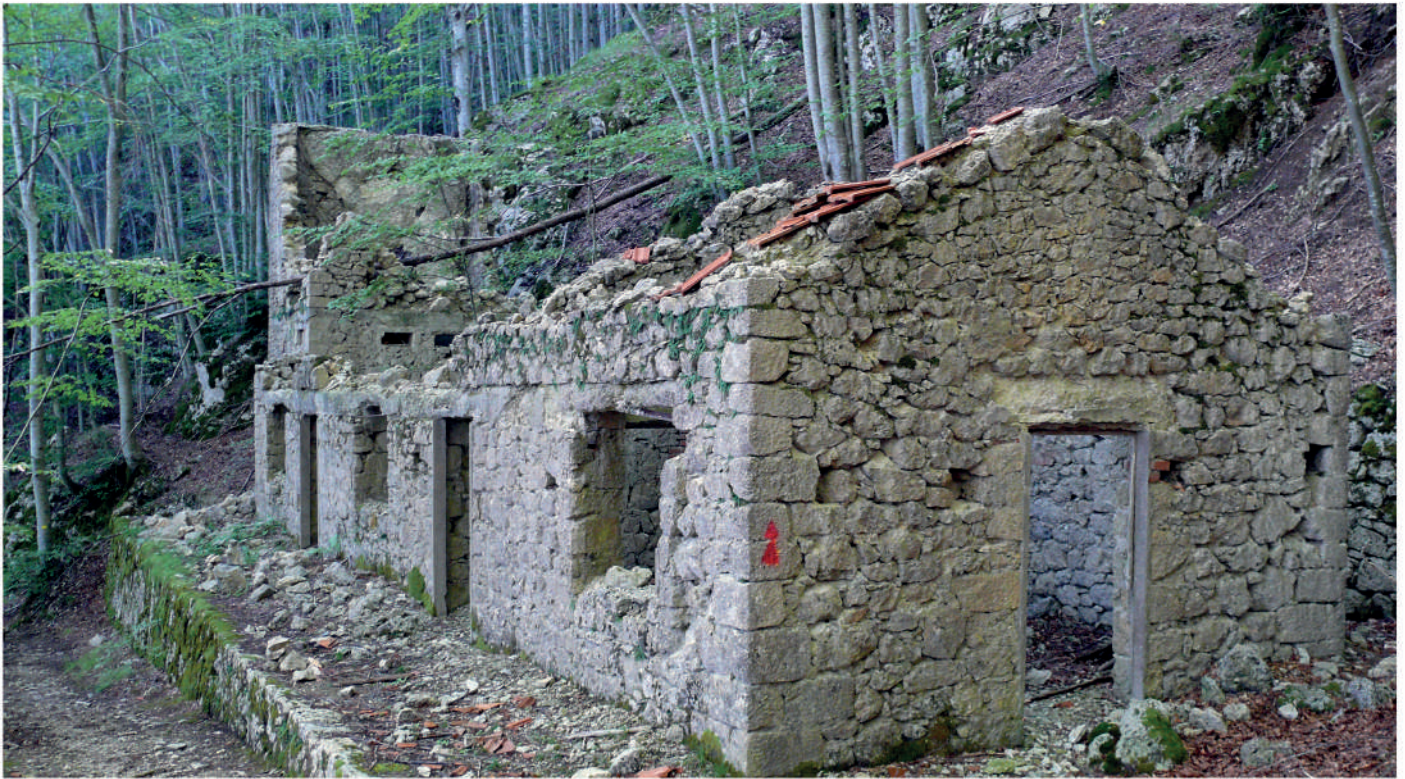
FOTO 1 locale con annessa cabina elettrica adiacente la miniera
