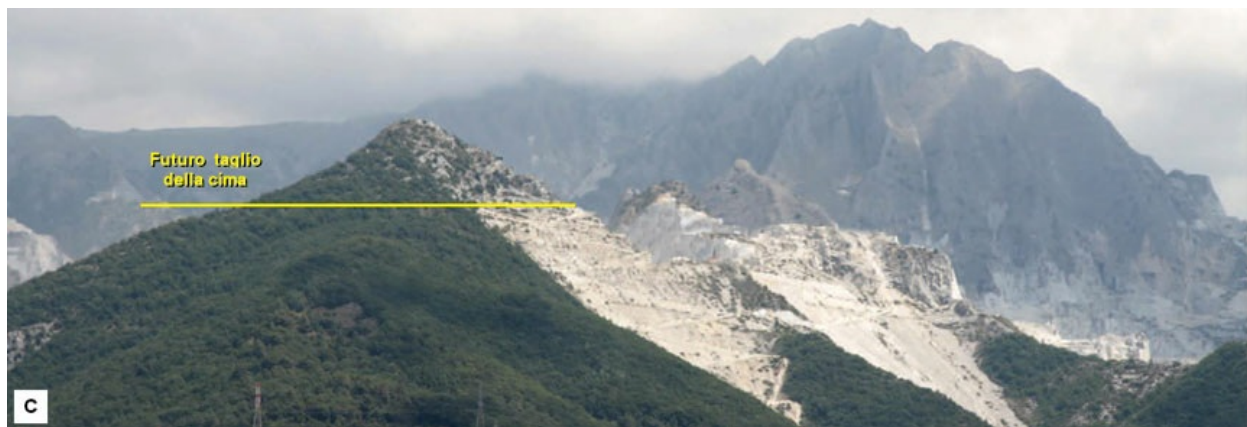
Fig. 3. Cave Betogli-Calocara viste da sud-ovest (da S. Martino). Confronto fra la situazione attuale (A) e le fotosimulazioni della prima fase (B: estrazione del 30% dell'autorizzazione precedente) e della fase successiva (C). Il taglio della cima da tergo prelude ad una futura fase del suo totale splateamento (presumibilmente lungo la linea continua in C), ritenuto necessario per il razionale sfruttamento della cava.
